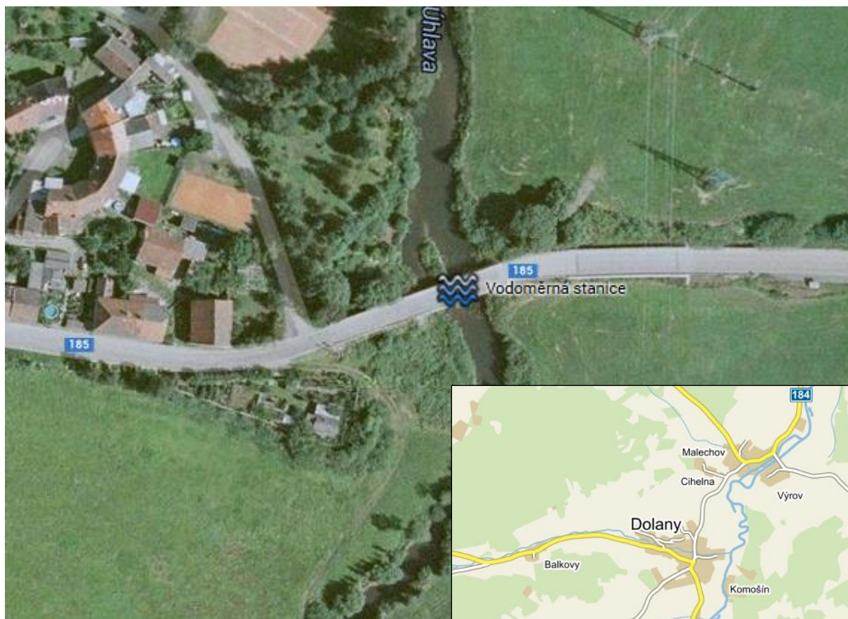
Umístění vodoměrné stanice v obci Dolany v místní části Svrčovec
